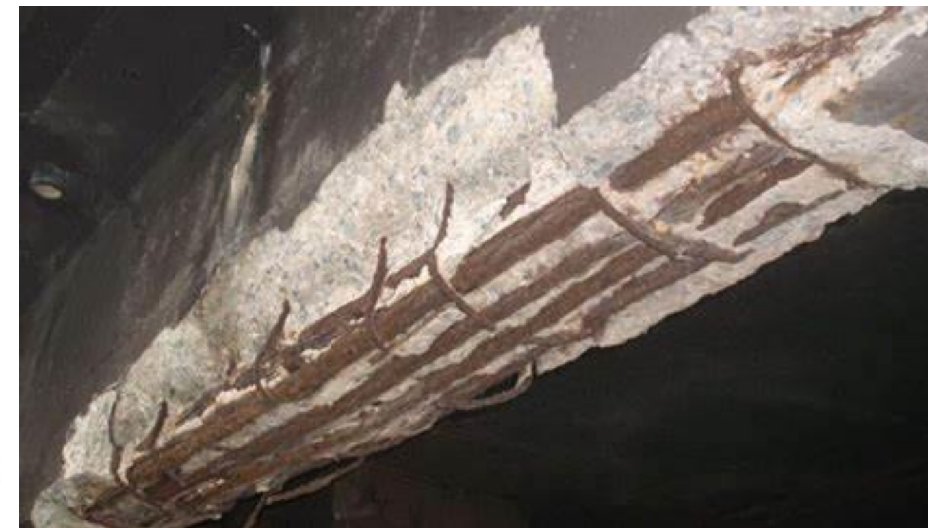
B) Fissuração devida as forças de expansão dos produtos de corrosão
